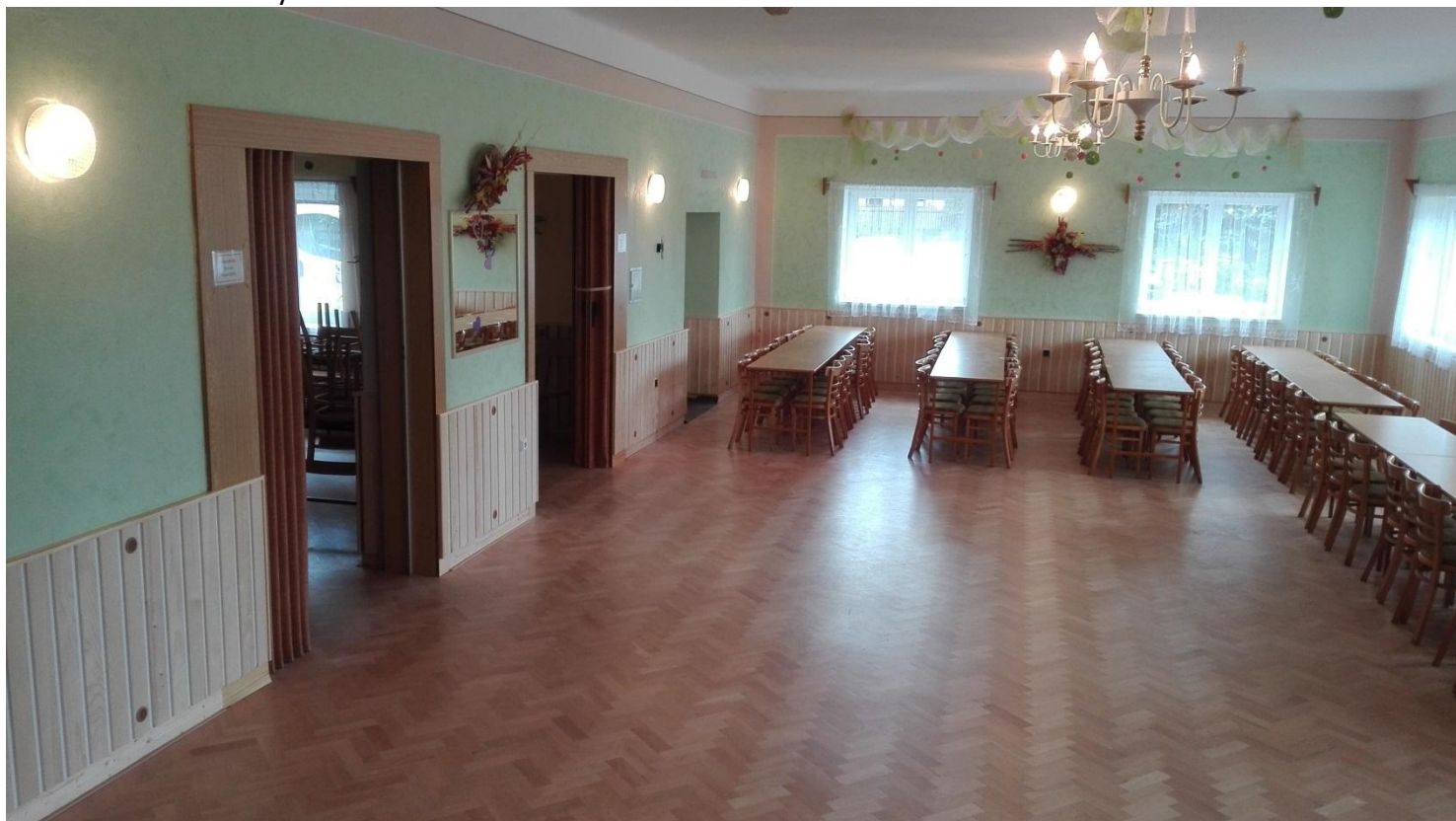
Obložení sálu dřevěným obkladem
